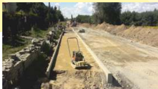
przebudowa ul. Poznańskiej
