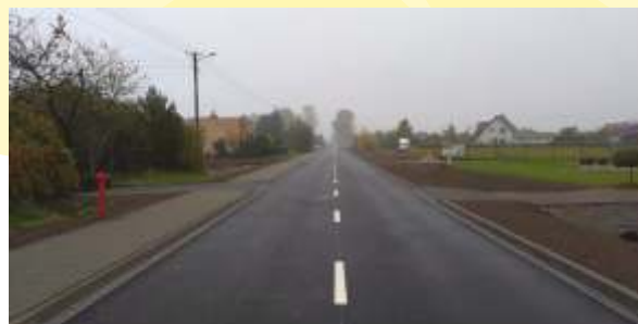
przebudowa ul. Poznańskiej
