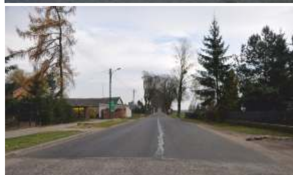
remont ul. Czarniejewskiej
