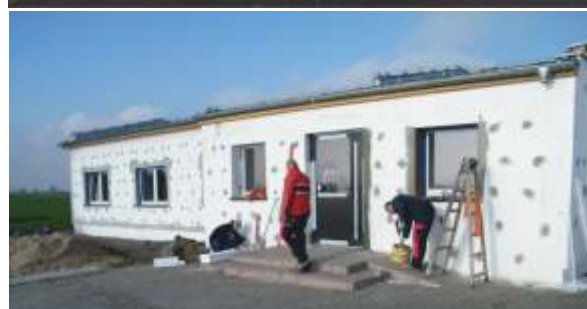
termomodernizacja i remont świetlicy w Latalicach
