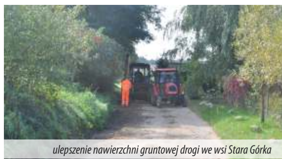
ulepszenie nawierzchni gruntowej ul.Śliwkowej w Biskupicach
