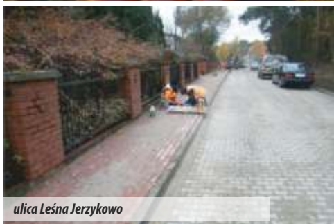
Budowa kanalizacji sanitarnej
