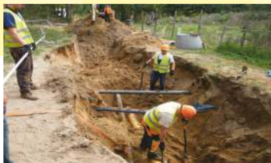
budowa sieci kanalizacji sanitarnej
