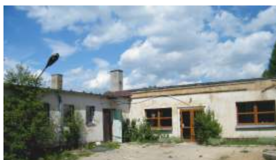
remont i adaptacja harcówki w Stęszewku
