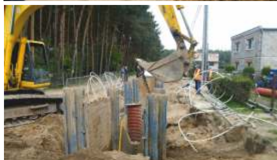
budowa sieci kanalizacji sanitarnej
