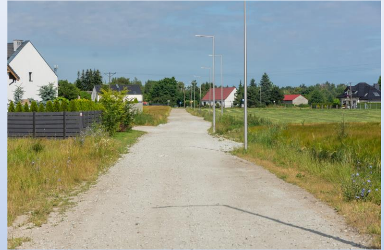
2. ul. Fiołkowej i odcinka ul. Zawilcowej w m. Pobiedziska
