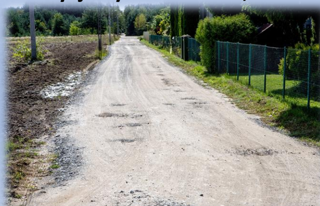
ul. Wypoczynkowa w Stęszewku
