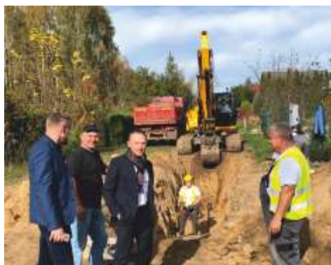
BUDOWA KANALIZACJI W JERZYKOWIE UL. NA SKARPIE
