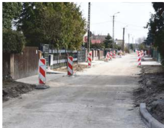
25. Budowa ulicy Różanej w Biskupicach.
