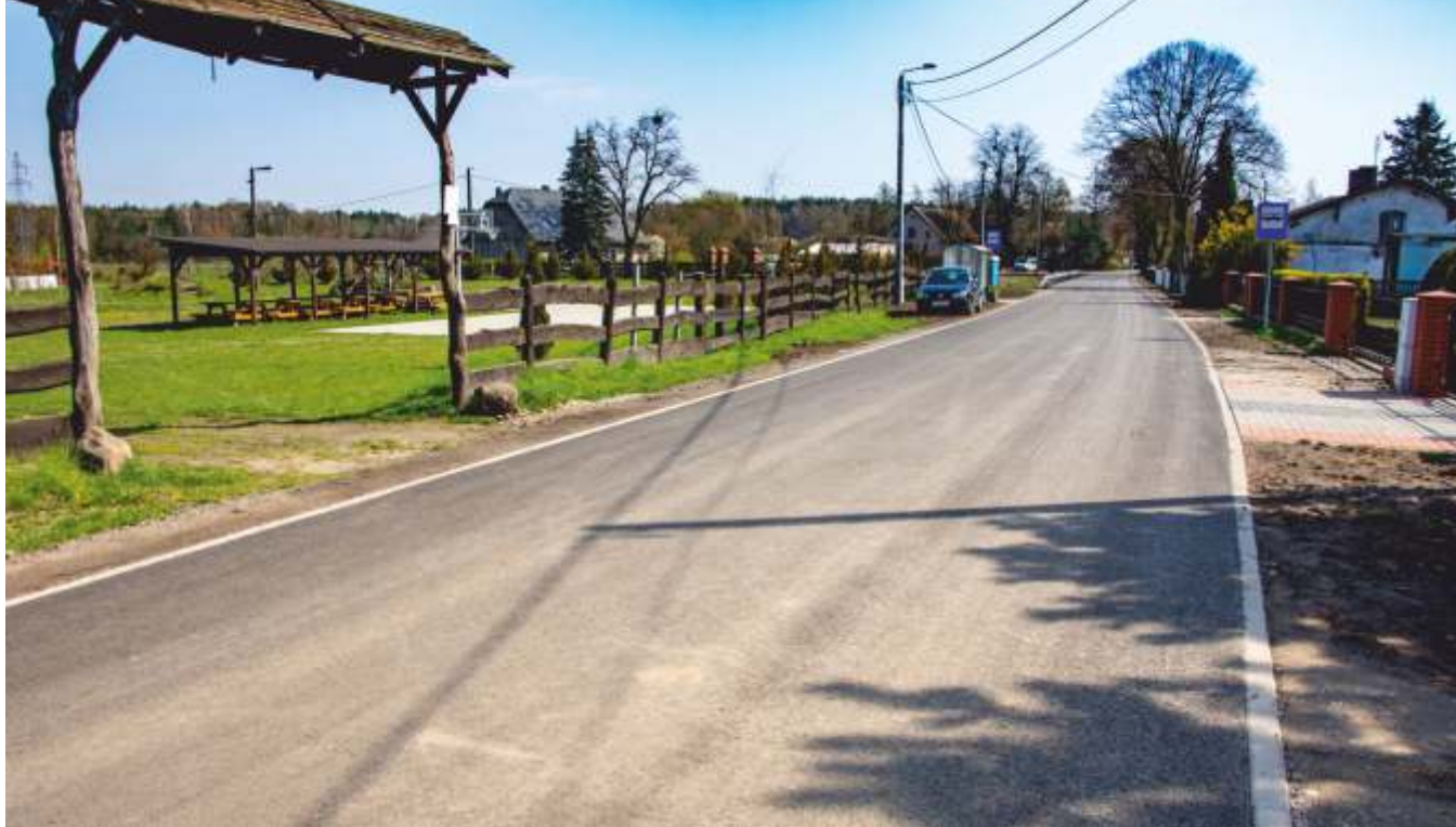
17. Przebudowa drogi Promno - Góra Etap II.
