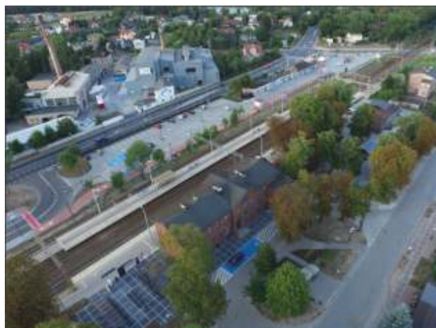
WĘZEŁ PRZESIADKOWY - POBIEDZISKA
