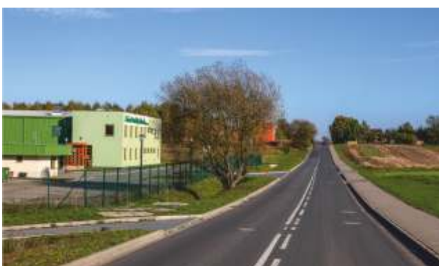
PRZEBUDOWA ULICY POZNAŃSKIEJ
