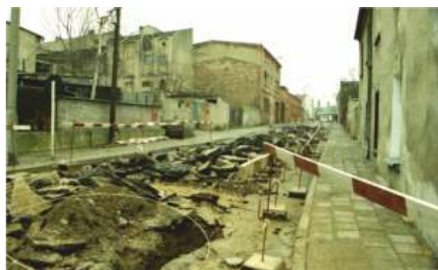
BUDOWA KANALIZACJI UL. WŁ. JAGIEŁŁY
