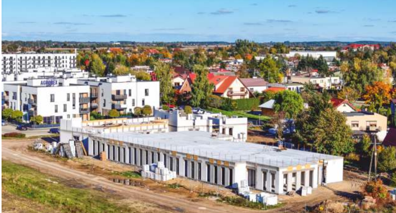
CENTRUM REHABILITACJI I EDUKACJI W POBIEDZISKACH - zdj. W. Borucki
