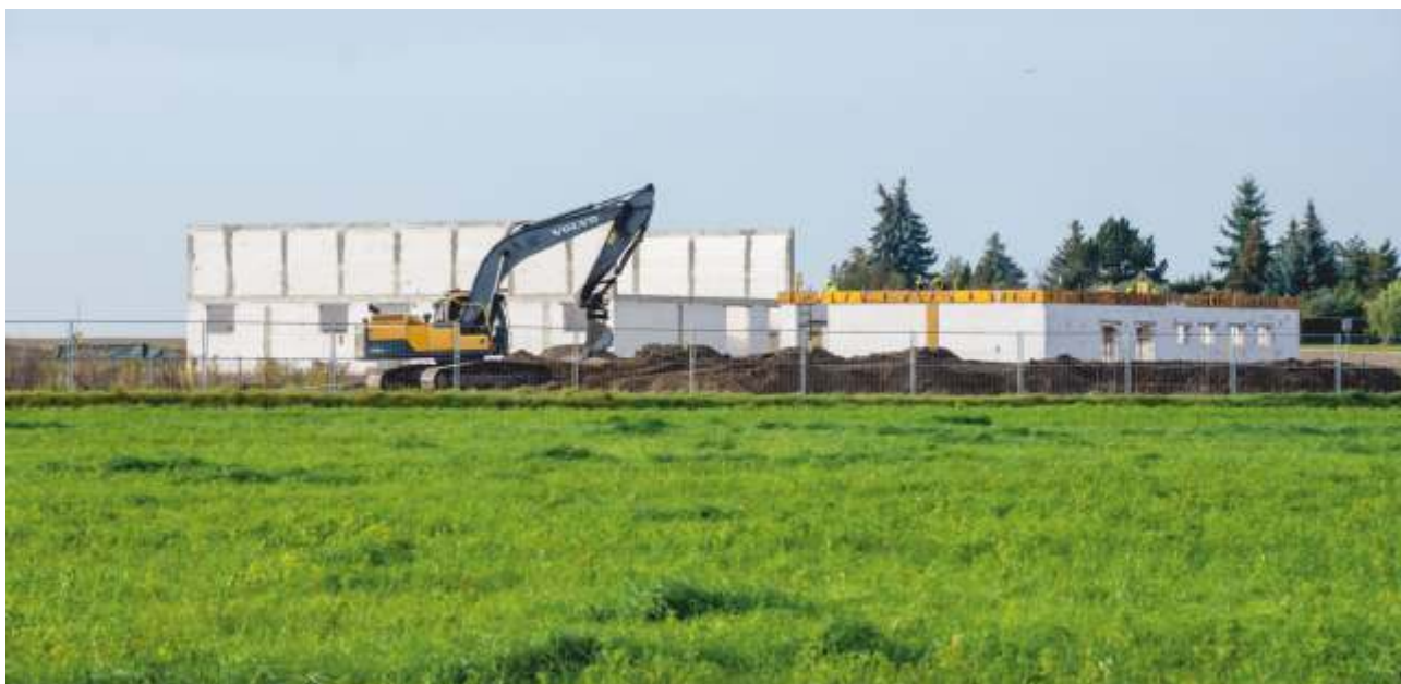
BUDOWA BOISKA I ZAPLECZA DLA BOISKA SPORTOWEGO
