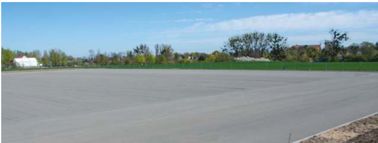
BUDOWA BOISKA PIŁKARSKIEGO
