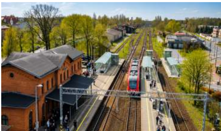
BUDOWA PODZIEMNYCH PRZEJŚĆ
