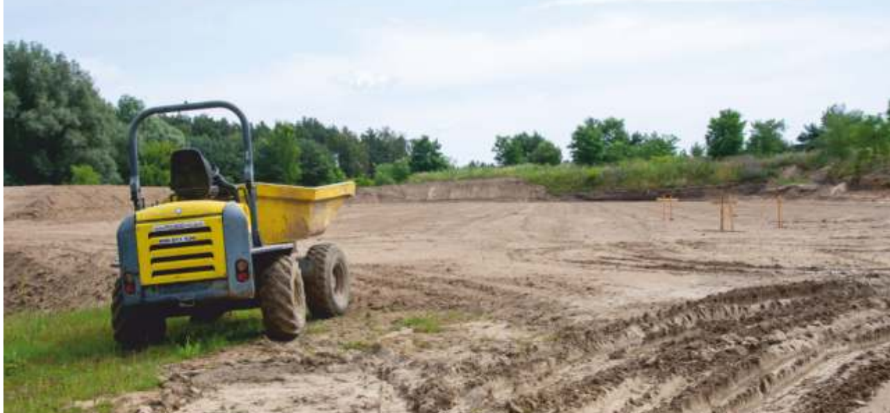
BUDOWA TORU ŁUCZNICZEGO
